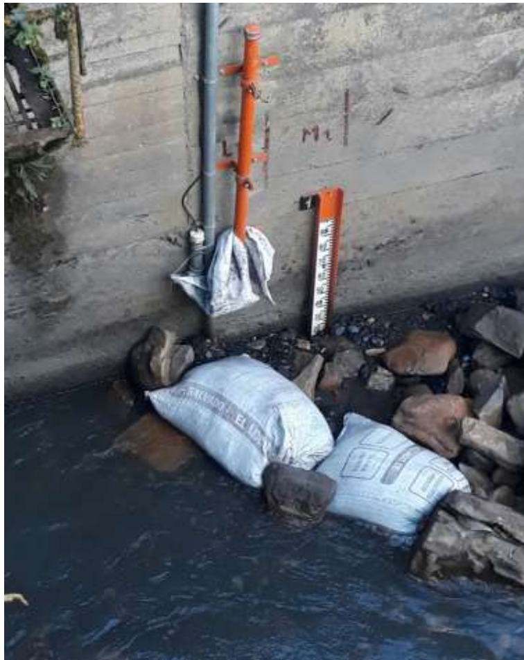
Desarrollo de obra
