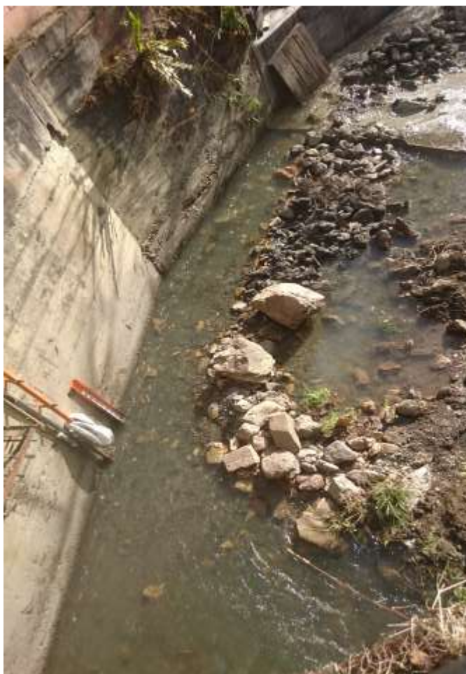
Estado actual de la quebrada.
