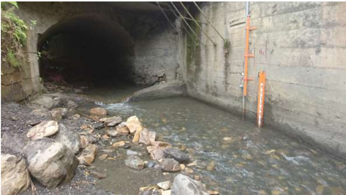
Inicio de la obra
