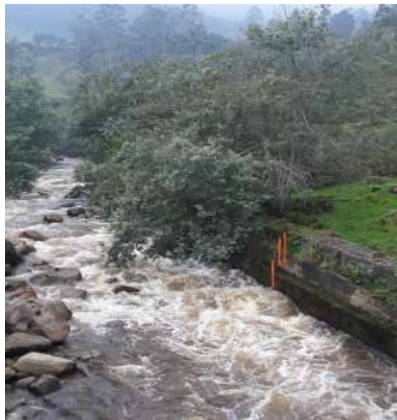
Estado actual de la estación hidrométrica.
