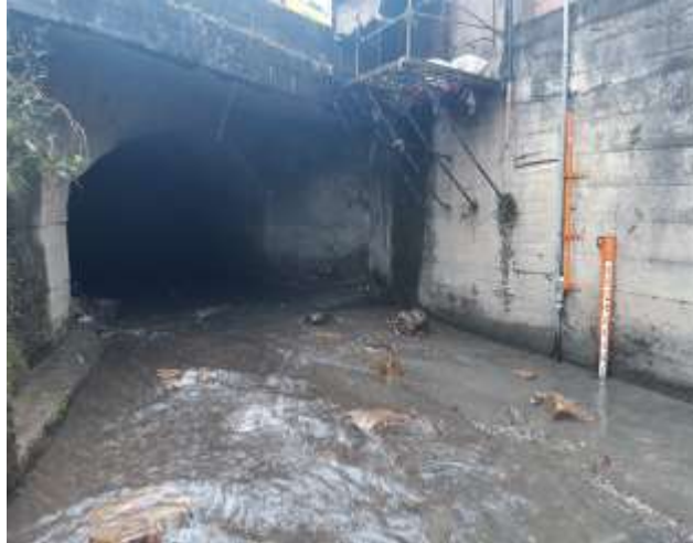
Estado actual de la estación hidrométrica
