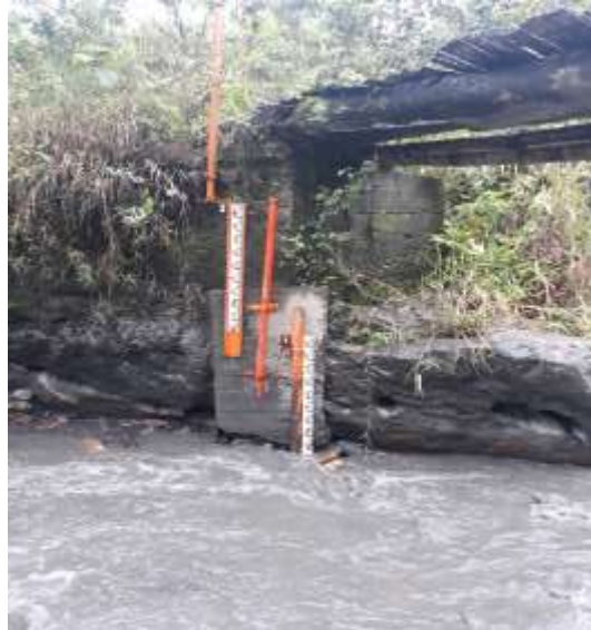
Estado actual de la estación hidrométrica
