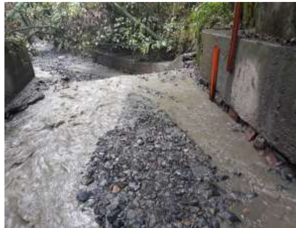
Estado actual de la estación hidrométrica
