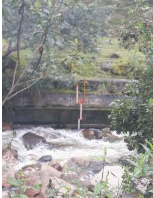
Estado actual de la estación hidrométrica.
