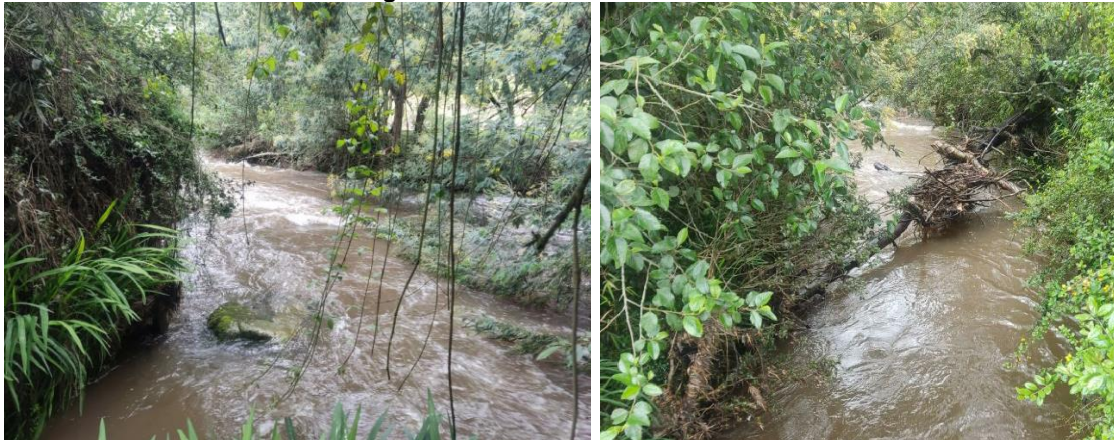
Fotografía 19 Procesos de socavación en el río Aves
