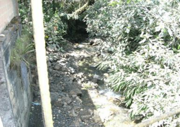
Fotografía N° 3.18: Morfología del chorro con un alto gradiente hidráulico y pared de la vivienda constituye la orilla de la quebrada.
