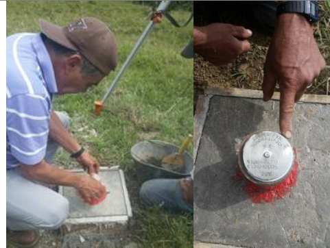
Fotografía N° 1.18: Mojón 2, instalación placa de aluminio.
