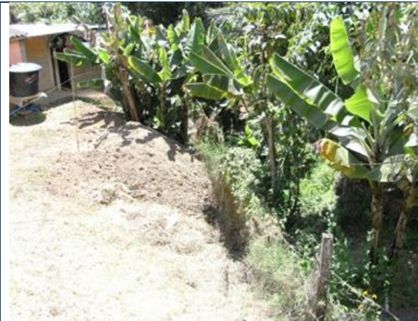
Fotografía N° 3.27: Rellenos sobre la ronda hídrica para ganar terreno y construcciones de viviendas en superficies coluviales abruptas.
