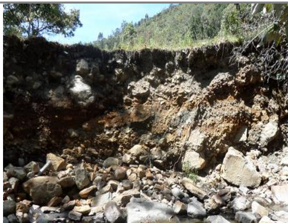
Fotografía N° 3.1: Suelos con material granular en la cuenca de la quebrada Grande – Municipio de Ubalá.
