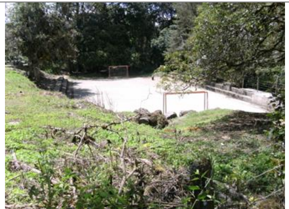
Fotografía N° 3.14: Acondicionamiento de una superficie coluvial para la construcción de una cancha.
