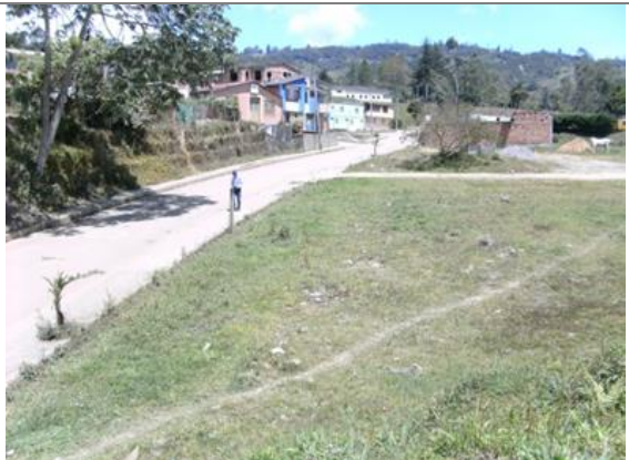
Fotografía N° 3.23: La ronda hídrica "desaparece" por el "entubamiento o enterramiento" del cauce para ganar superficie.
