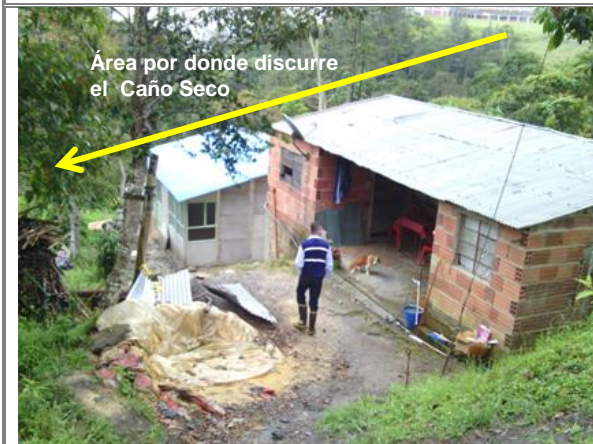
Fotografía N° 1.13: Muros de viviendas demarcando la ronda del caño Seco.
