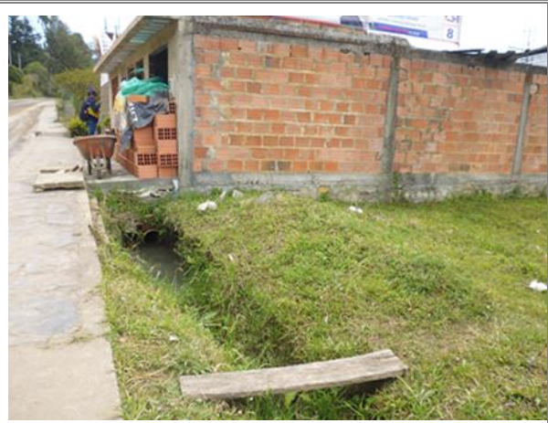
Fotografía N° 1.2: Se evidencia que el caño fue canalizado y sobre él se elevó la construcción. Fuente: PI Planificación Integral Consultores S.A.S, 2015.
