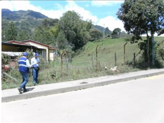
Fotografía N° 3.21: Interferencia en la delimitación de la ronda hídrica por la construcción de viviendas.
