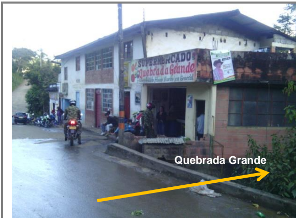
Fotografía N° 1.11: Muros de viviendas demarcando la ronda de la quebrada Grande.
