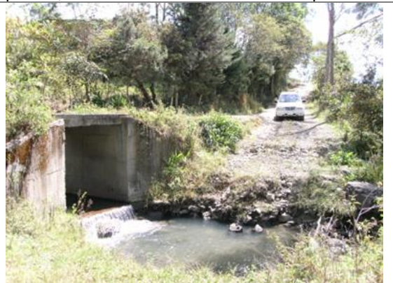
Fotografía N° 3.11: Chorro eyectado después del estrangulamiento o “efecto venturi”. Morfología característica de una corriente con un alto gradiente hidráulico.
