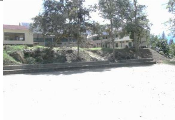
Fotografía N° 3.16: Obra civil que restringe drásticamente la amplitud de la ronda hídrica.
