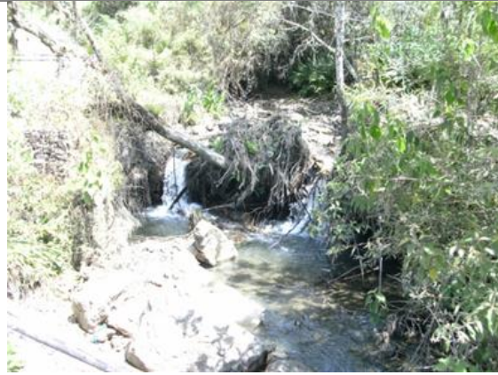
Fotografía N° 3.9: “Embotellamiento” antes del estrangulamiento del cauce por construcción de puente, sin considerar la dinámica de la quebrada.
