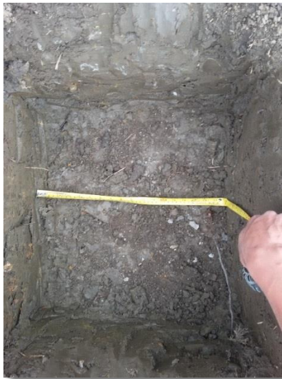
Foto 30. Construcción de la base para el dado de concreto.
