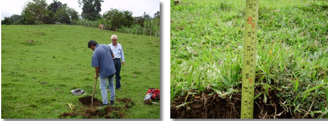
Foto 25. Excavación para fundir mojones.
