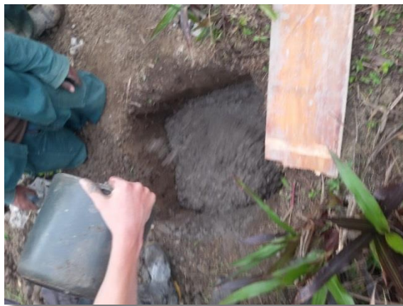
Foto 31. Llenado de la base para materialización del dado de concreto.
