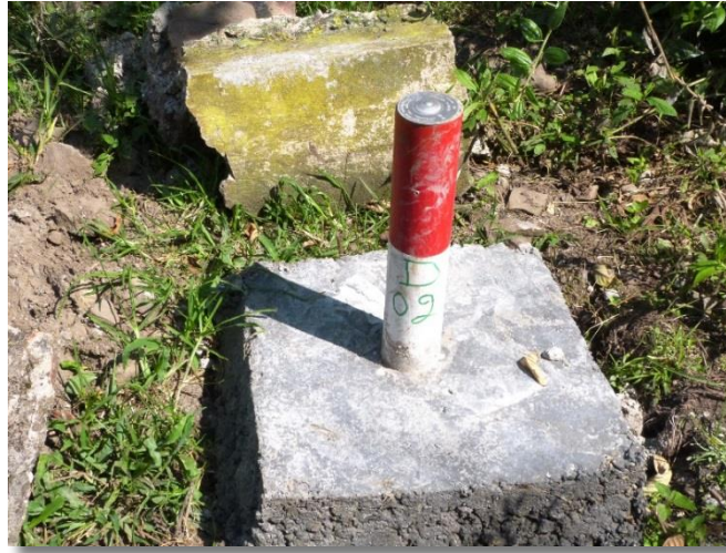
Foto 34. Colocación de la placa de aluminio con tornillo embebido en el concreto.
