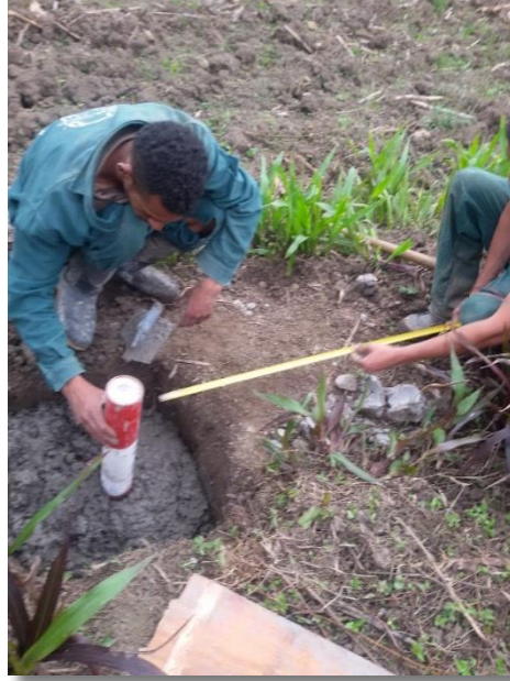
Foto 32. Anclaje del tubo de PVC al concreto.
