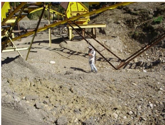
Foto 22. Localización de las coordenadas con el Rover.
