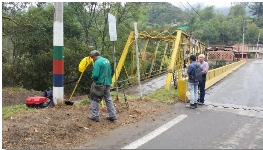
Foto 19. Armada del punto auxiliar 4A.
