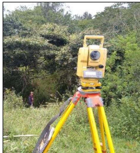
Figura 22. Levantamiento de información topográfica con Estación Topcon GTS 233W.
