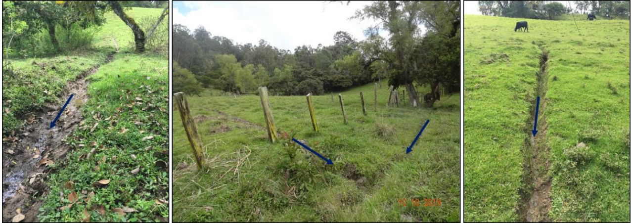
Figura 95. Zanjas de desagüe en la quebrada la esperanza
