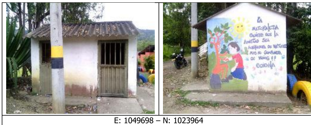
Fotografía 2. Centro de acopio de basuras
