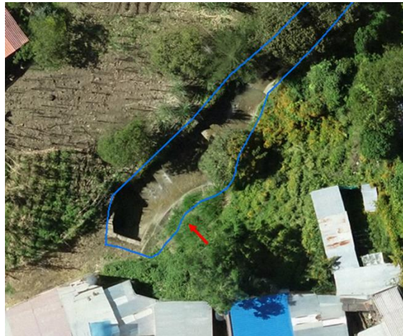
Figura 10.5. Inicio de canalización a través de tubería del cauce la de Quebrada El Chulo - año 2022
