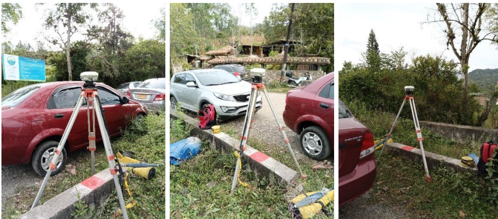
Fotografía 6.3. Posicionamiento vértice GPS-2
