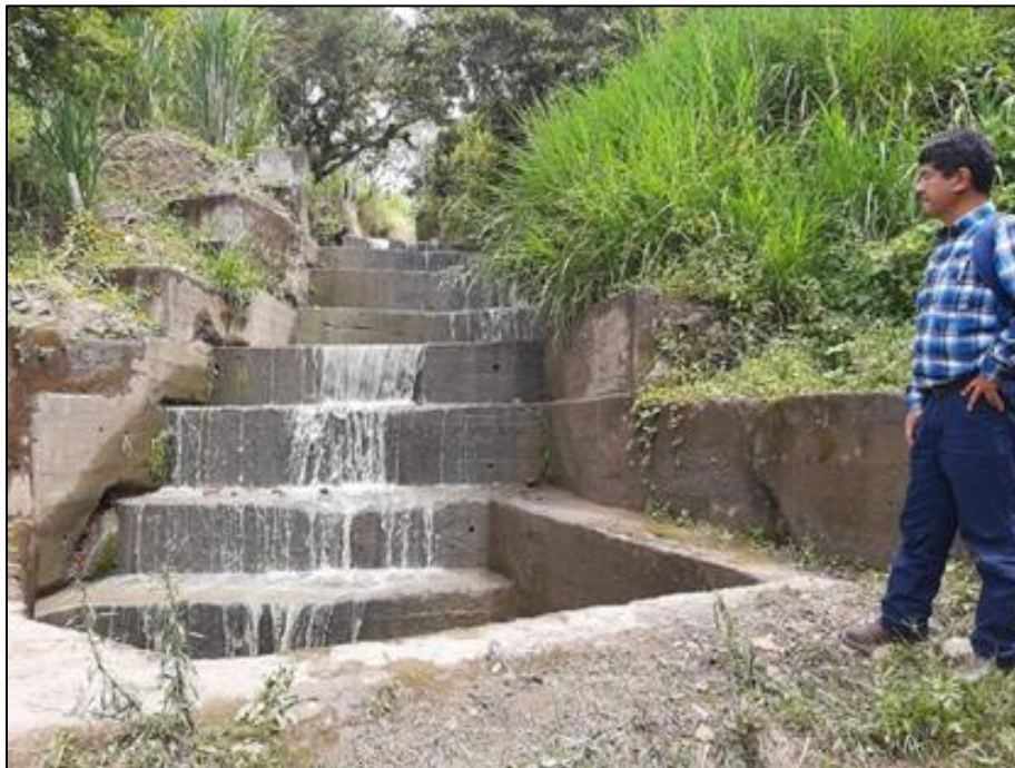
Fotografía 11.5. Canal en la Quebrada El Chulo (Ac) (Norte: 2090320,50719/Este: 4929749,61664)
