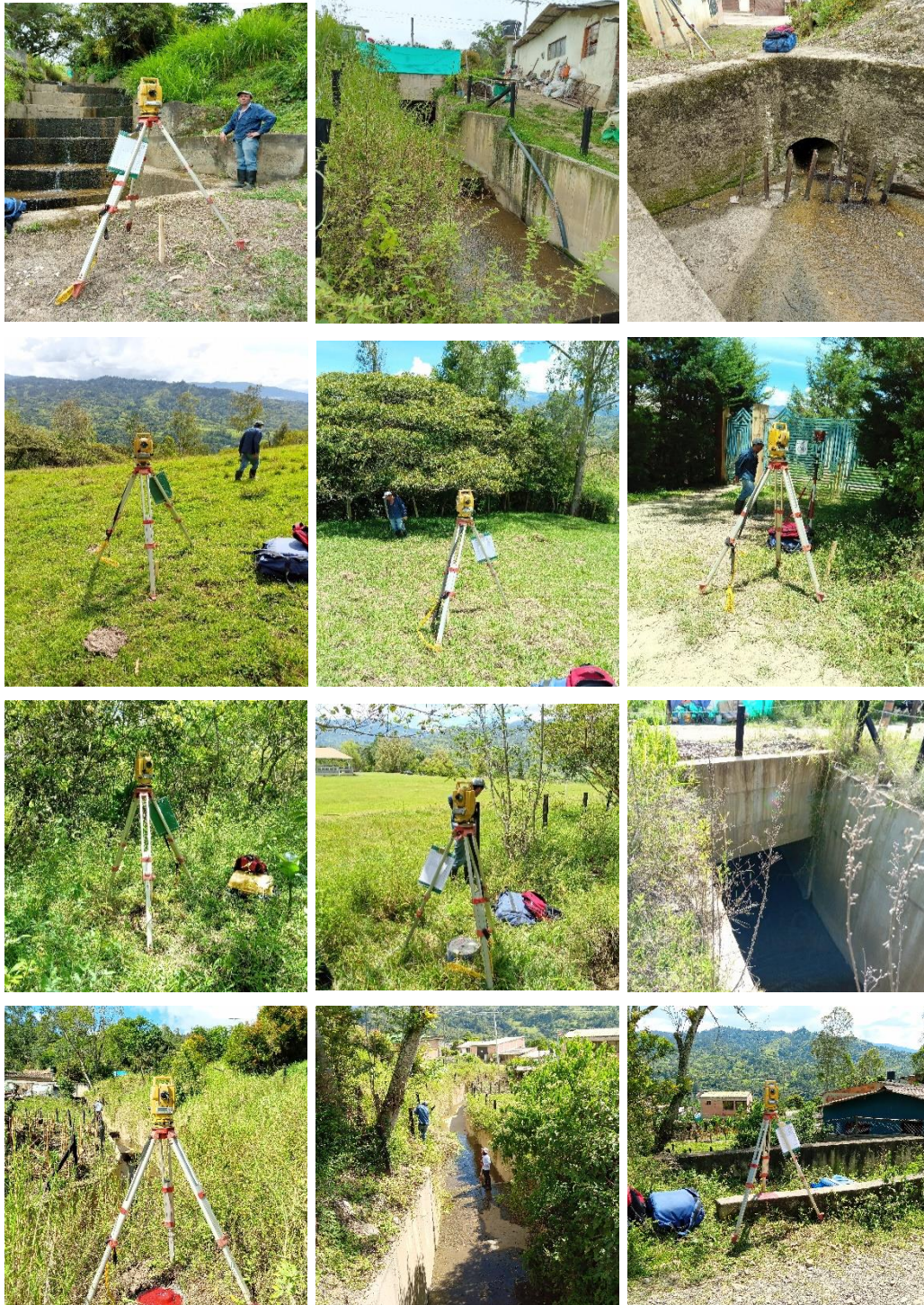
Fotografía 6.6. Levantamiento Topobatómico Estación Total
